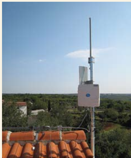
ADSL je spojen bežičnom mrežom između Kanfanara i Ladići na način optičke vidljivosti. Jedna je točka bila antena na dimnjaku zgrade općine a druga na zgradi Pescamara u Ladići
