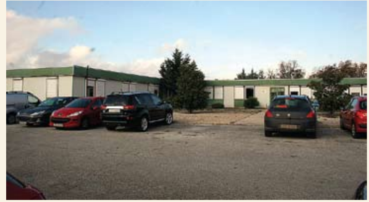
U bazi graditelja francuskog Bouyguesa kraj čvora Kanfanar ističu da je na gradilištima trenutno angažirano 400 radnika
